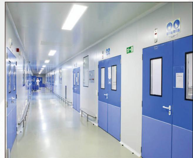
این پانل از نوع دیواری بوده و در ساخت کلین روم (اتاق تمیز) کاربرد دارد. معمولاً در ضخامت ٦ سانتی متر تولید می شوند و عمدۀ تفاوت آن با ساندوچ پانل دیواری معمولی صاف بودن این پانل ها می باشد، زیرا برای ساخت فضاهای کلین روم ساندوچ پانل می بایست سطح کاملاً صاف و بدون فرم باشد تا ذرات معلق موجود در فضا در شکل فرم پانل ها جمع آوری نشوند. کیفیت ساندوچ پانل کلین روم (دو رو صاف) آریا بارون در سطح استانداردهای جهانی می باشد. همچنین محل اتصال دو پانل بسیار گیرا بوده و به طور ایده آلی به هم متصل می شوند.
